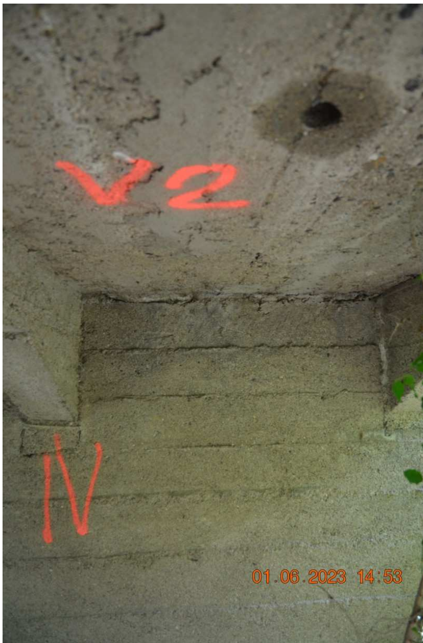
Svislý vývrt V2 zespodu do pohledu D 50 mm v 6. poli
