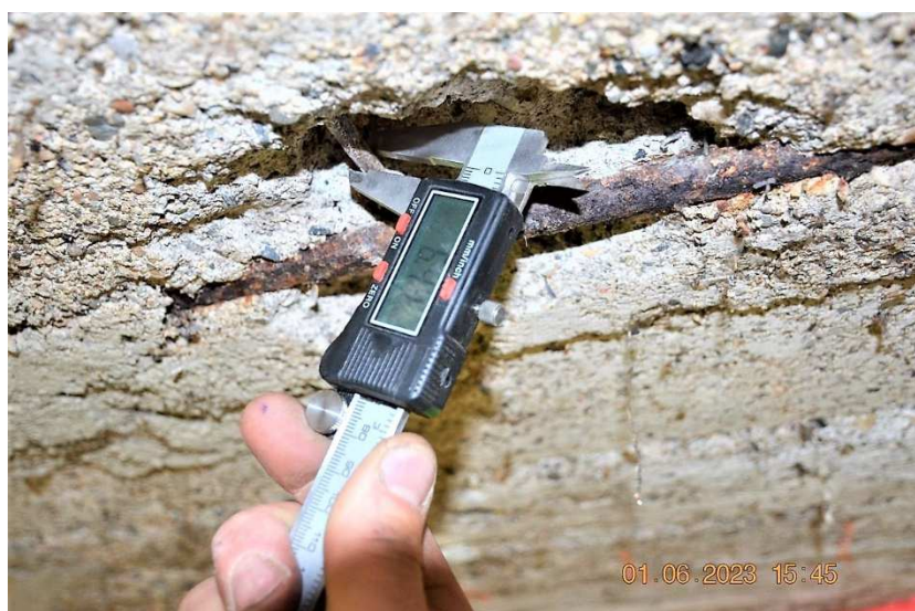
Příčná výztuž v desce rámových polí.
