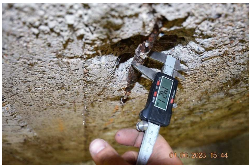
Podélná výztuž v desce rámových polí.
