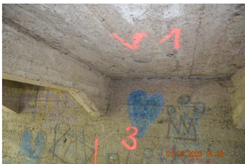
Svislý vývrt V1 zespodu do pohledu D 50 mm ve 4. poli
