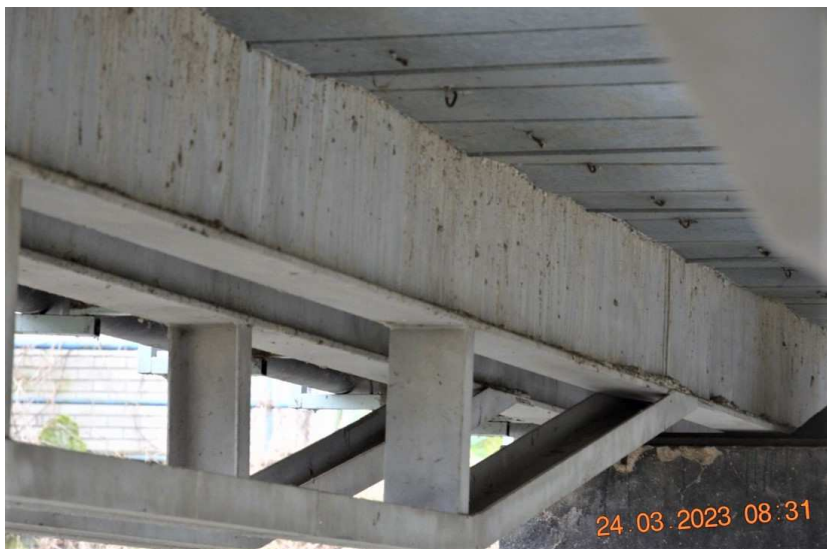
Podhled nosné konstrukce se vzpínadly – oka ztraceného bednění korodují.
