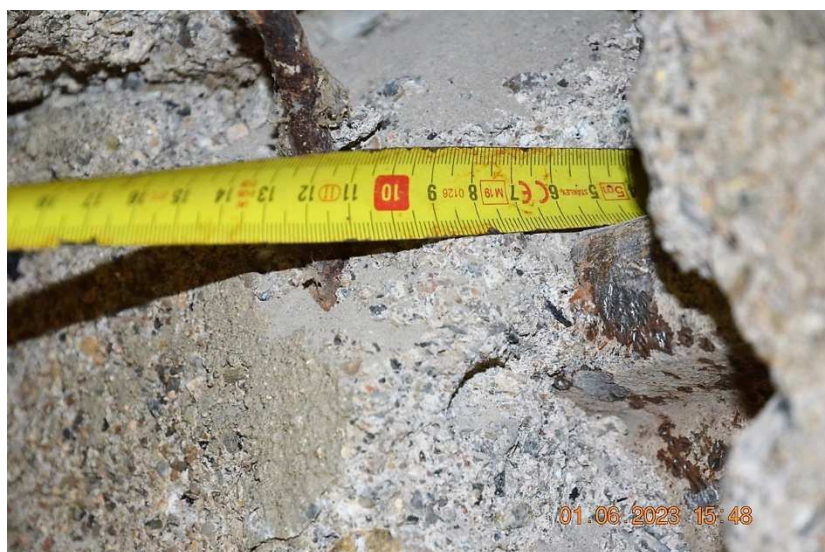
Šířka hlavy zabetonované kolejnice.
