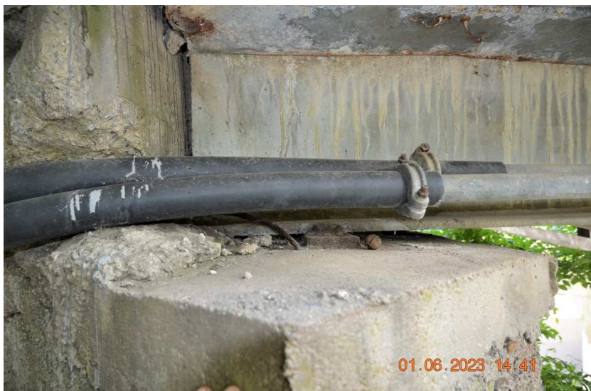
Podpěra 3 zleva s chráničkami pro elektrické kabely.
