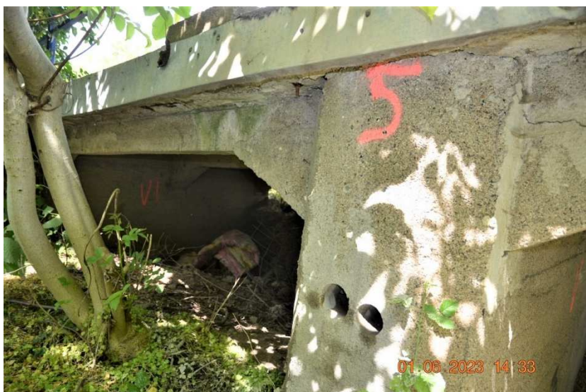
Vývrty 5 D 75 mm a 5A D 100 mm na boku podpěry 7 vlevo byl provedeny ve dvou průměrech kvůli velkým zrnům kameniva.
