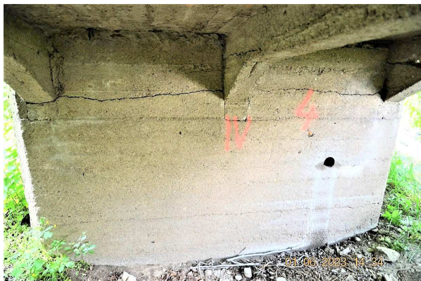
Održená nosní konstrukce od podpěry.
