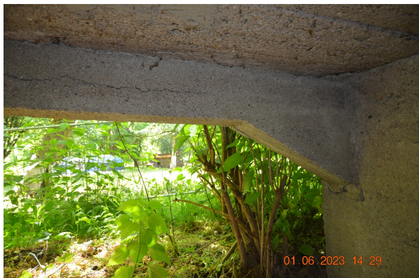
Trhlina v trámů od nadměrných průhybů.
