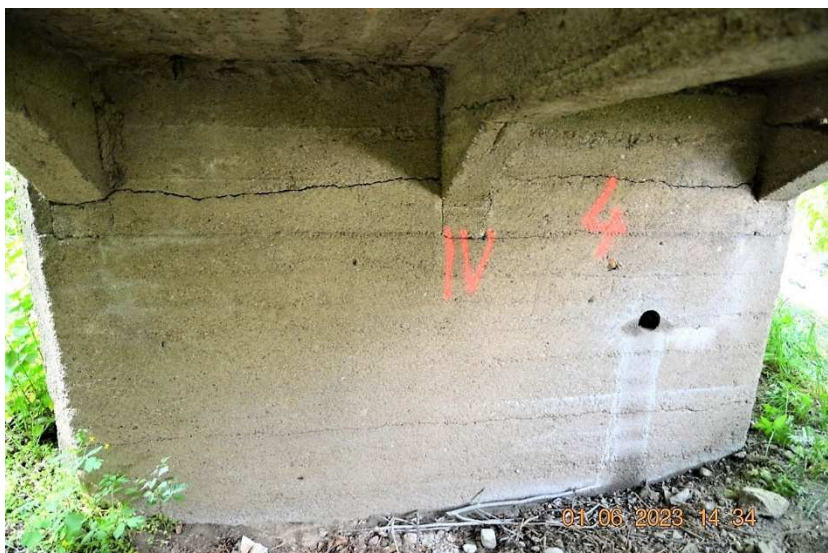
Vývrt 4 D 100 mm do podpěry 6 v 6. poli.
