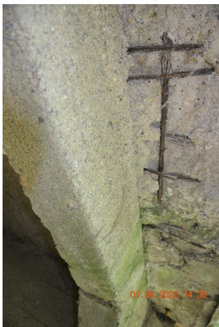
Na jediném místě vlevo je beton římsy zespodu zdegradovaný a výztuž překorodovaná.
