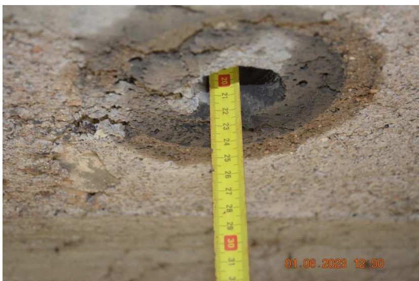
Svislý vývrt V3 zespodu do pohledu D 50 mm v 6. poli, tloušťka desky včetně vozovka je 200 mm.
