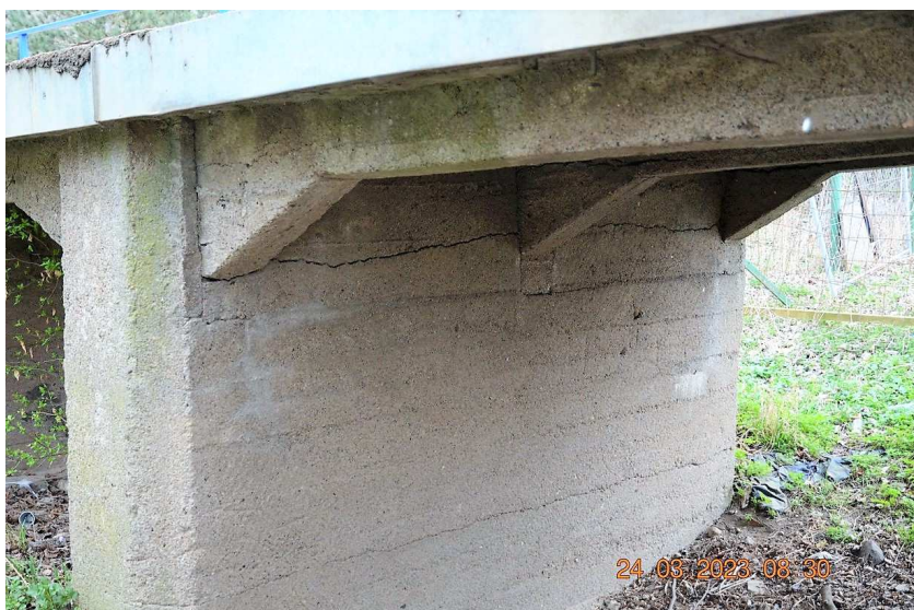
Pilíř IV – vetknutí nosné konstrukce je kompletně utržené.
