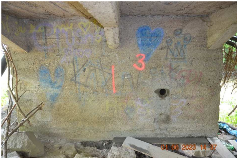
Vývrt 3 D 100 mm do podpěry 4 ve 4. poli.
