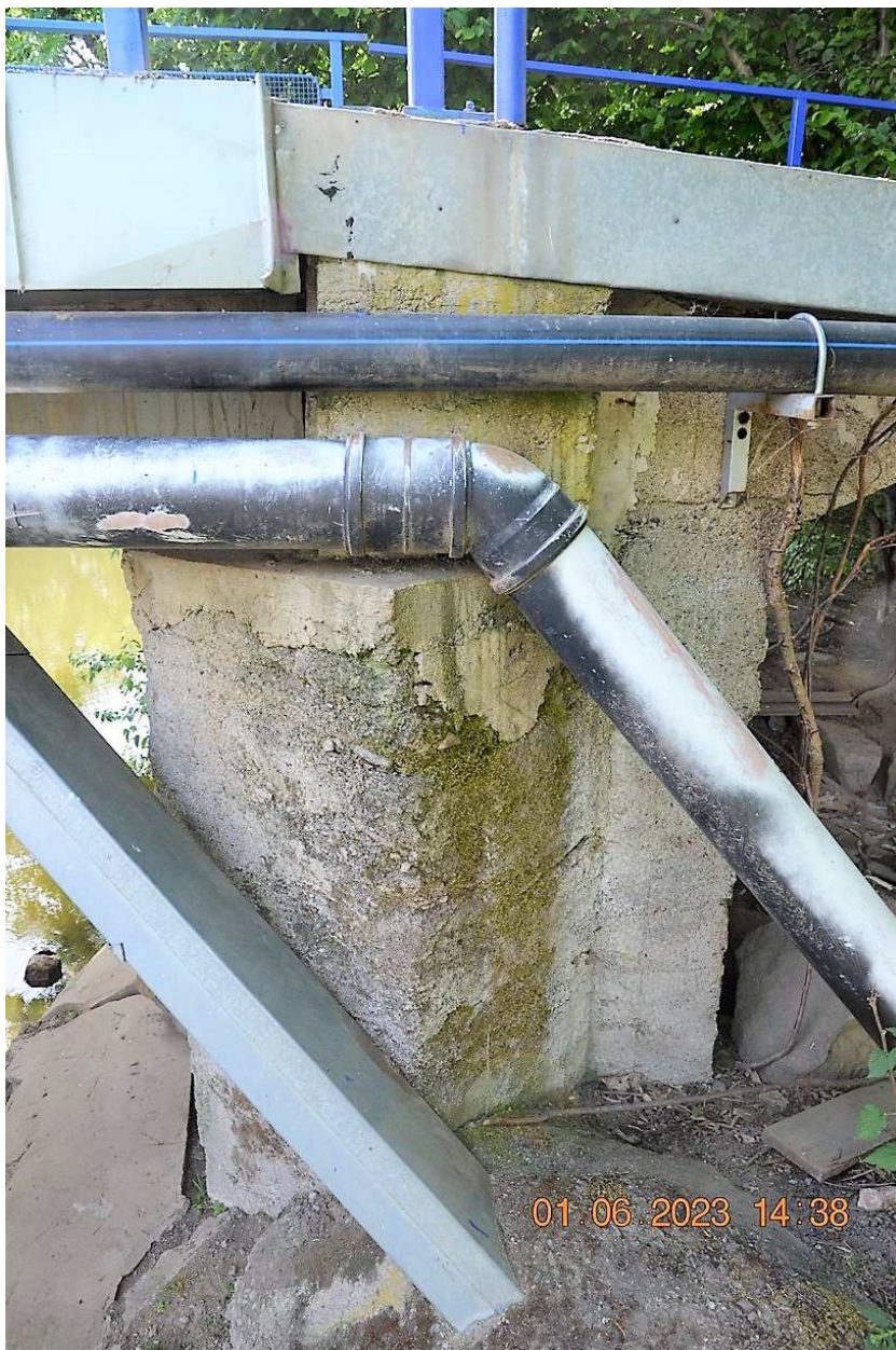
Podpěra 3 zprava na povodní straně s kabelovým žlabem, splaškovou kanalizací a vodovodem.
